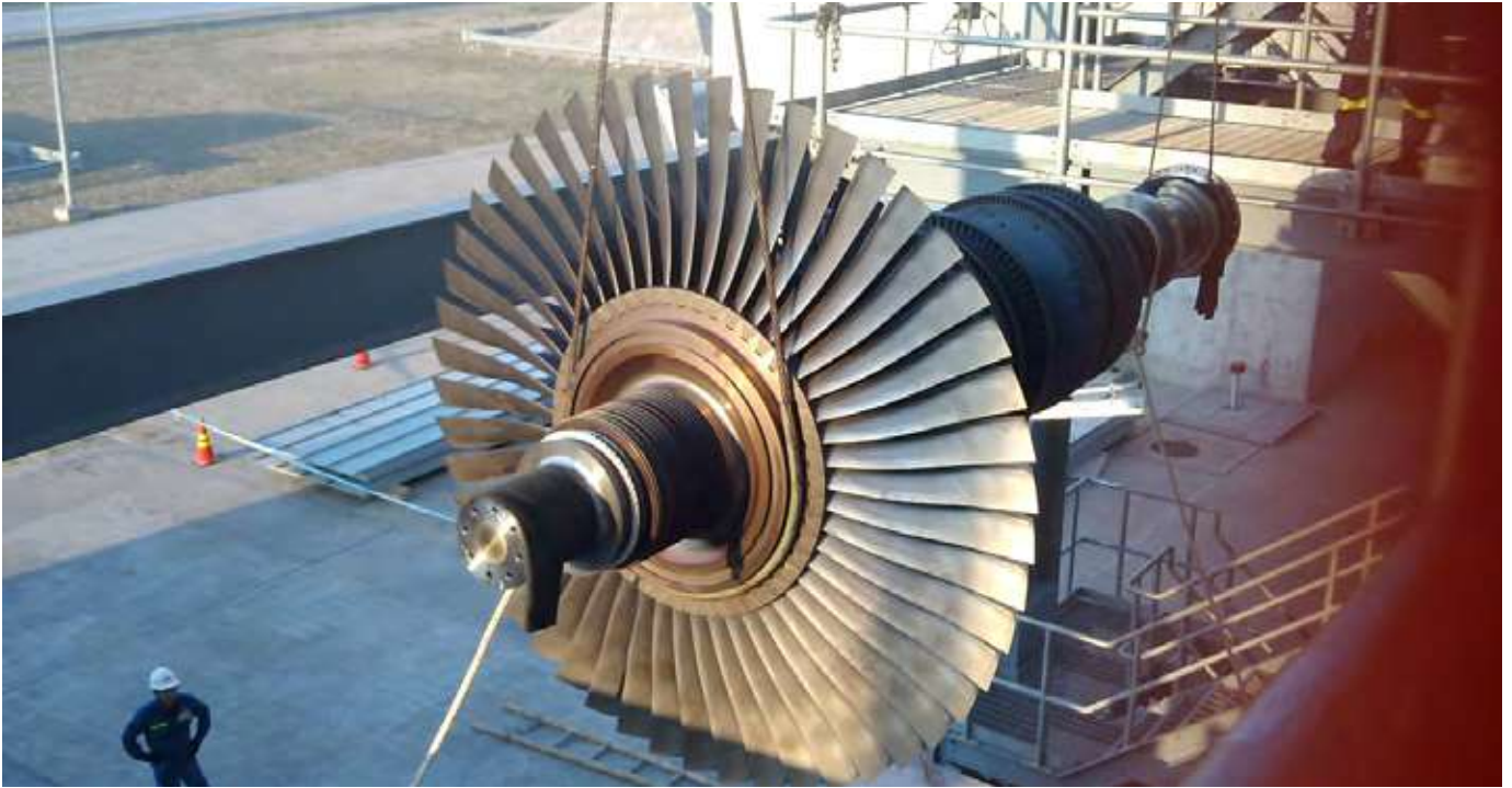
Tháo lắp, Sửa chữa và căn chỉnh lại turbine No.: 113-ST- 101A; tốc độ vòng quay 6556 v/p tại Nhà máy Lọc hóa dầu Nghi sơn – Thanh Hóa/ Removable, Repair & Re alignment Turbine No.: 113-ST- 101A; speed 6556 r/m at NSRP
