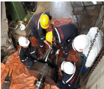
Sửa chữa quạt nhà máy ANP Thái Bình/ Repairing fans of Thai Binh ANP factory
