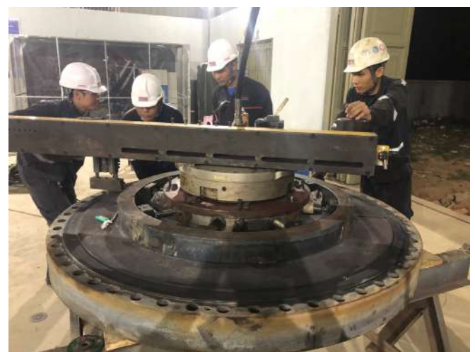
Gia công, tạo mặt phẳng bề mặt gương của mặt bích tại Nhà máy lọc hóa dầu Nghi sơn - Thanh Hóa/ Facing, Re-Facing & Flating at NSRP.
