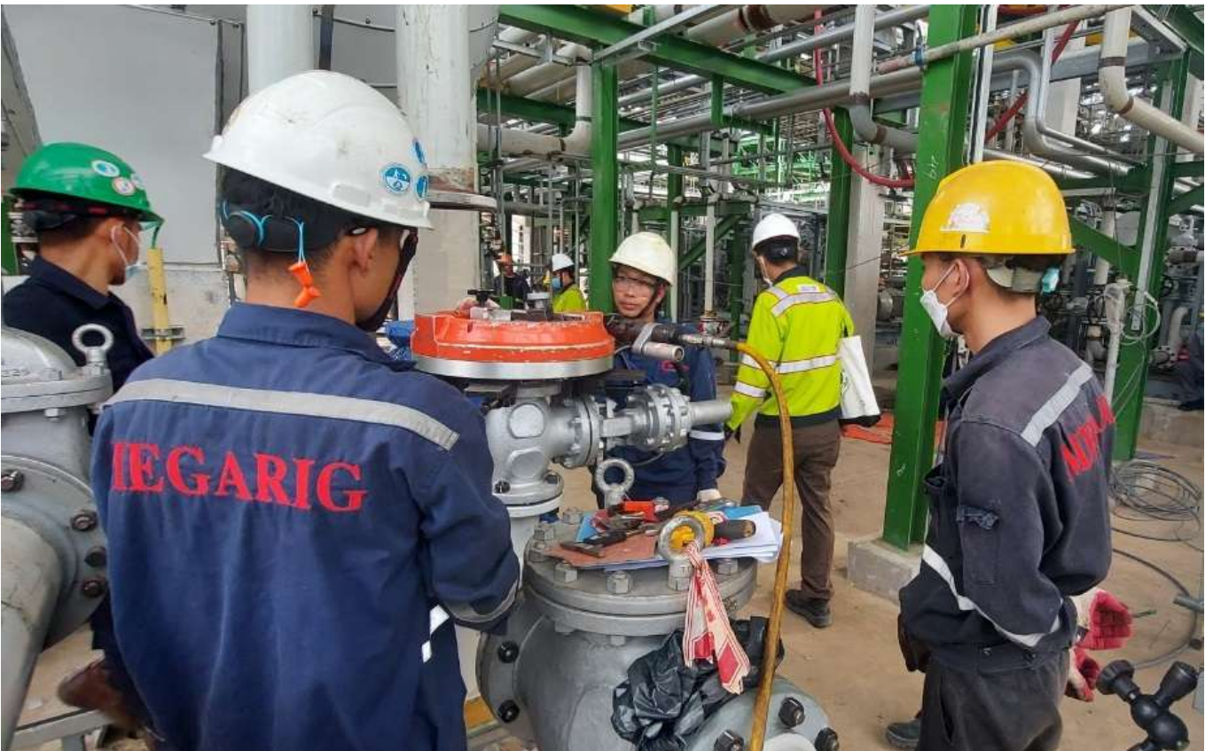
Gia công, tạo mặt phẳng bề mặt gương của mặt bích tại Nhà máy lọc hóa dầu Long sơn / Facing, Re-Facing & Flating at BRVT .
