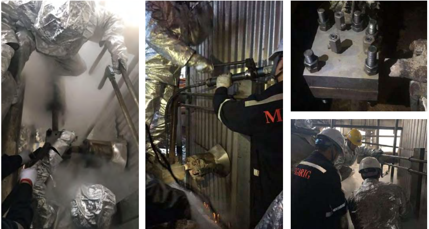
Sửa chữa rò rỉ online đường ống cấp nước lò hơi tại Nhà máy đạm Hà Bắc/ Repairing leaks online for boiler water supply pipes at Ha Bac Nitrogenous Plant
