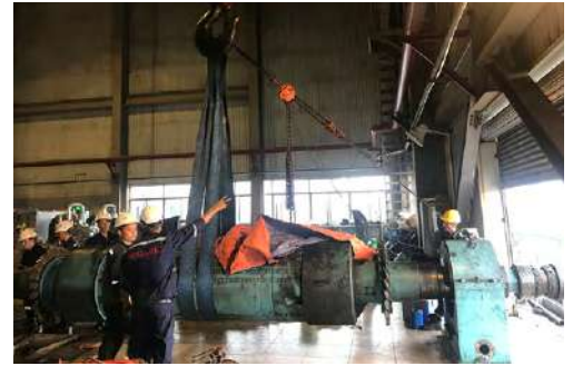
Đại tu Tuabin, Nhà phát và Thiết bị phụ lò số 2 - Nhà máy Nhiệt Điện Cao Ngạn / Overhaul of Tuabine, Generator and Furace auxiliary equipment no.2 - Cao Ngan thermal power plant.
