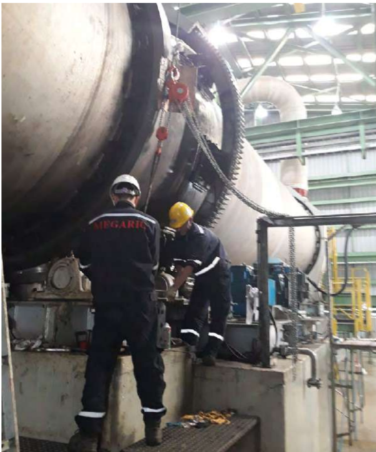
Sửa chữa, bảo dưỡng, căn chỉnh và thay vòng bi của thiết bị Nhà máy ANP Thái Bình/ Repair, maintenance, alignment and replacement bearings of ANP Thai Binh Plant equipment
