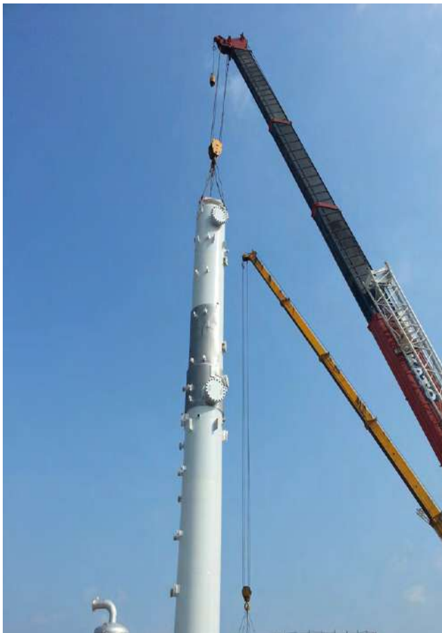
Lắp đặt thiết bị tĩnh tại Nhà máy khí Vũng Tàu/Static Equipment installation at Vung Tau PVGAS Plant/
