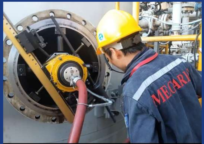
Gia công, tạo mặt phẳng bề mặt gương của mặt bích tại Nhà máy lọc hóa dầu Bình Sơn - Quảng Ngãi/ Facing, Re-Facing & Flating at Dung Quat Refinery Plant (BSR).
