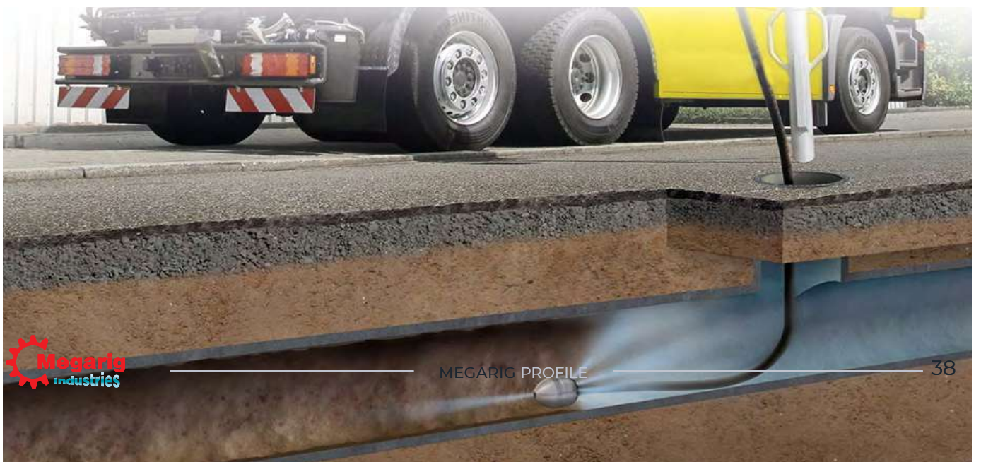
Thiết kế mô hình 3D làm sạch bên trong đường ống bằng nước áp lực cao ống xoay 3D model design for Roto-Hose water jet cleaning system.
