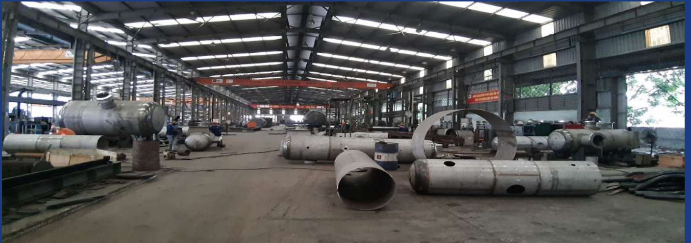
Lắp đặt thiết bị tĩnh tại Nhà máy khí Vũng Tàu/Static Equipment installation at Vung Tau PVGAS Plant/
