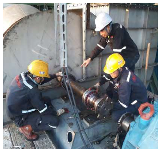
Sửa chữa, bảo dưỡng, căn chỉnh và thay vòng bi của thiết bị Nhà máy ANP Thái Bình/ Repair, maintenance, alignment and replacement bearings of ANP Thai Binh Plant equipment
