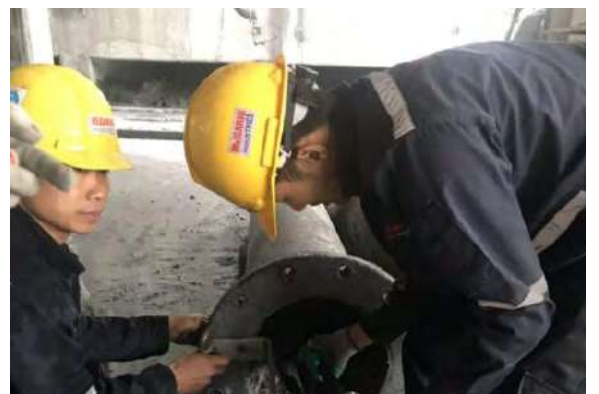
Làm sạch bên trong đường ống bằng nước áp lực cao tại Nhà máy hóa chất DAP2 - Lào Cai Jet cleaning for pipeline at Lao Cai DAP2 factory
