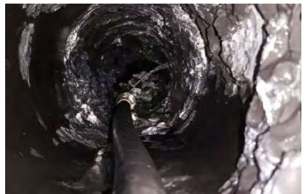
Làm sạch bên trong đường ống bằng nước áp lực cao tại Nhà máy lọc hóa dầu Bình Sơn - Quảng Ngãi Jet cleaning for pipeline at Dung Quat Refinery Plant (BSR)
