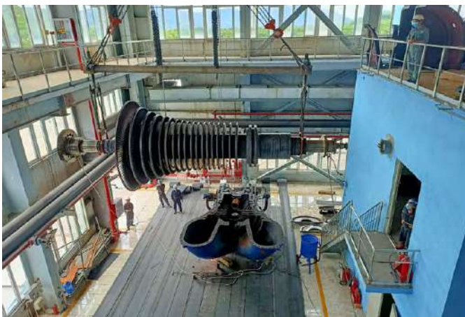
Thi công sửa chữa Tuabin Nhà máy Nhiệt Điện Nông Sơn / Construction and repair of turbines for Nong Son Thermal Power Plant
