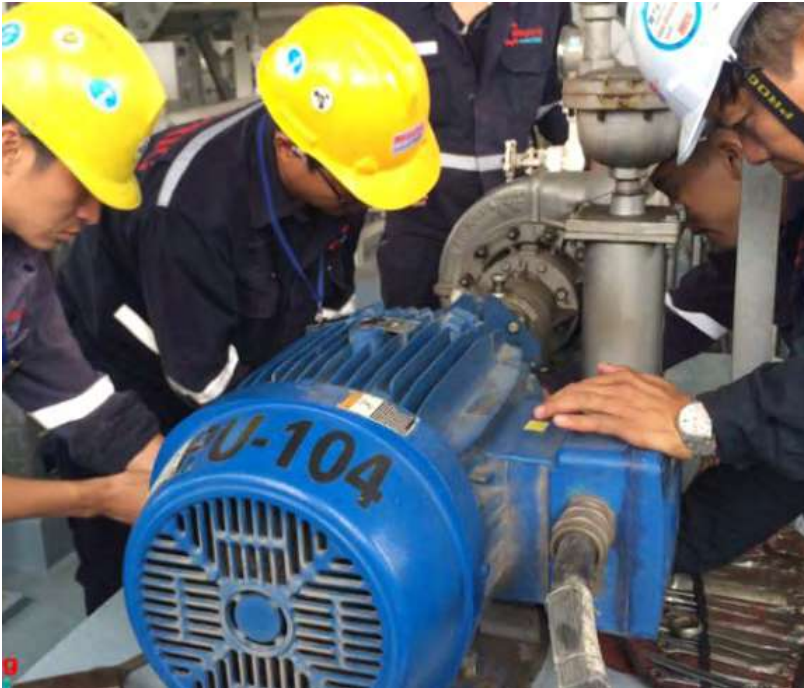
Sửa chữa và căn chỉnh Bơm tiếp nhận Công ty cổ phần dịch vụ nhiên liệu hàng không Nội Bài/ Repair and alignment feed pumps at Noi Bai Aviation Fuel Services Joint Stock Company
