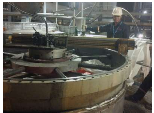
Gia công lại bề mặt bộ trao đổi nhiệt tại nhà máy lọc hóa dầu Nghi Sơn/Heat exchanger re-facing at NSRP.
