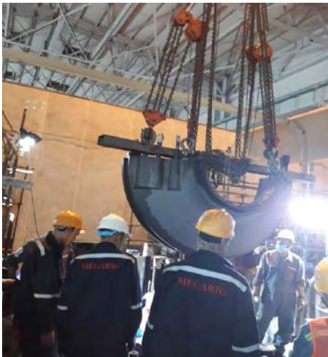
Tháo lắp, Sửa chữa và căn chỉnh lại turbine No.: 113-ST- 101A; tốc độ vòng quay 6556 v/p tại Nhà máy Lọc hóa dầu Nghi sơn – Thanh Hóa/ Removable, Repair & Re alignment Turbine No.: 113-ST- 101A; speed 6556 r/m at NSRP
