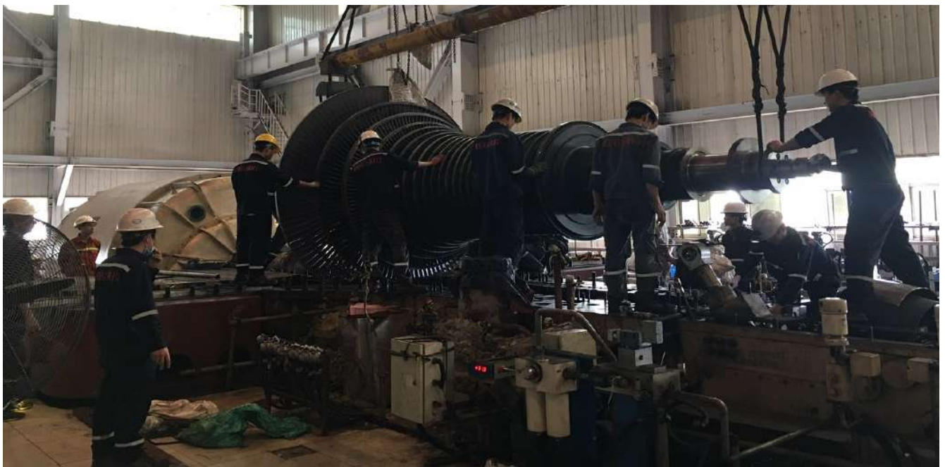
Đại tu Tuabin, Nhà phát và Thiết bị phụ lò số 2 - Nhà máy Nhiệt Điện Cao Ngạn / Overhaul of Tuabine, Generator and Furace auxiliary equipment no.2 - Cao Ngan thermal power plant.
