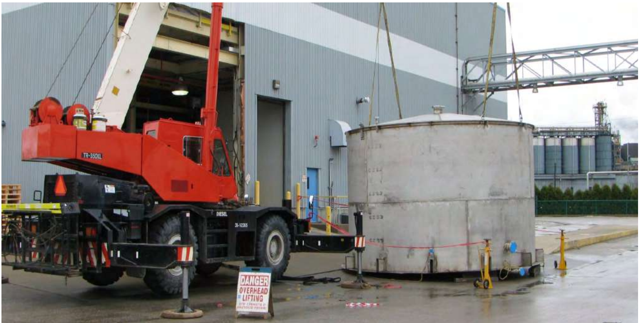
Lắp đặt thiết bị tĩnh/Static Equipment installation
