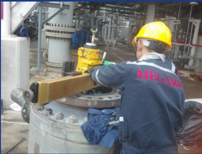
Gia công, tạo mặt phẳng bề mặt gương của mặt bích tại Nhà máy lọc hóa dầu Bình Sơn - Quảng Ngãi/ Facing, Re-Facing & Flating at Dung Quat Refinery Plant (BSR).
