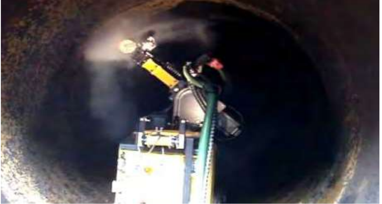
Làm sạch bên trong đường ống bằng nước áp lực cao tại Nhà máy lọc hóa dầu Bình Sơn - Quảng Ngãi Jet cleaning for pipeline at Dung Quat Refinery Plant (BSR)
