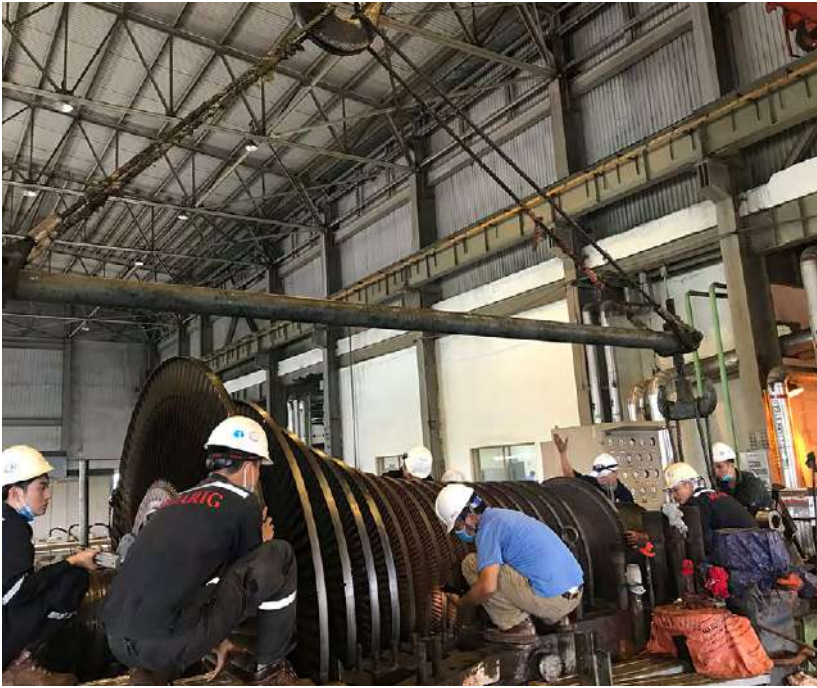
Đại tu Tuabin, Nhà phát và Thiết bị phụ lò số 2 - Nhà máy Nhiệt Điện Cao Ngạn / Overhaul of Tuabine, Generator and Furace auxiliary equipment no.2 - Cao Ngan thermal power plant.
