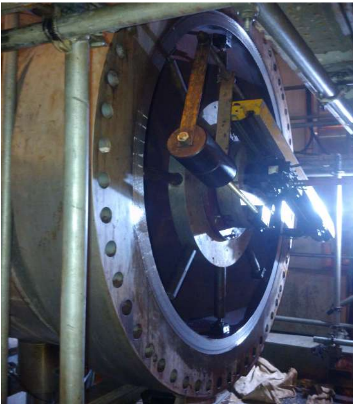
Gia công lại bề mặt bộ trao đổi nhiệt tại nhà máy lọc hóa dầu Nghi Sơn/Heat exchanger re-facing at NSRP.
